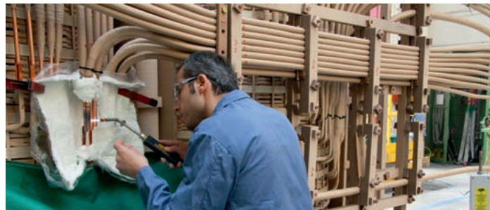
Пайка выводов обмотки 40 МВА 230 кВ
