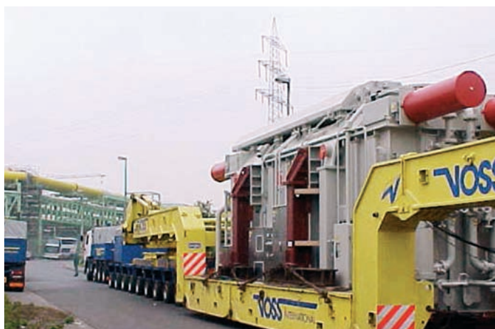
Транспортировка повышающего генератор-трансформатора 332 МВА (с водяным охлаждением); 115/21 кВ для немецкой энергетической компании RWE
