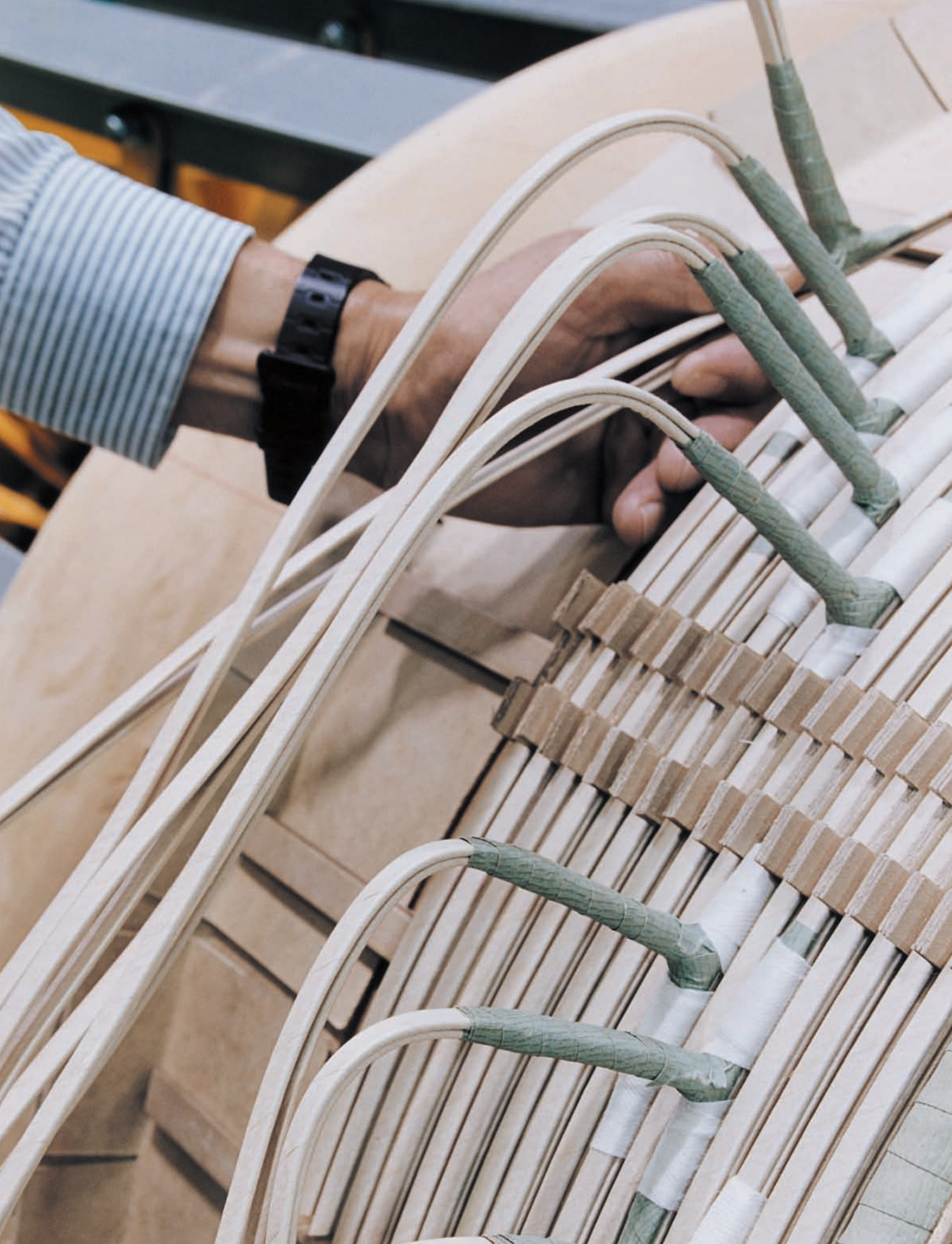
Изготовление регулировочных ответвлений из двухжильного медного провода
