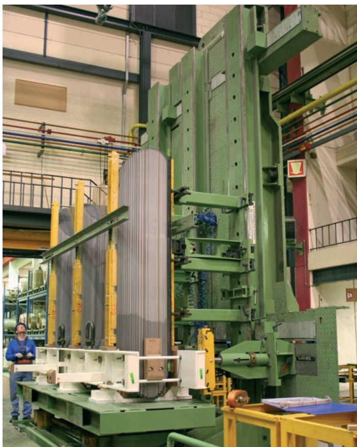
Монтаж магнитопровода после шихтовки
