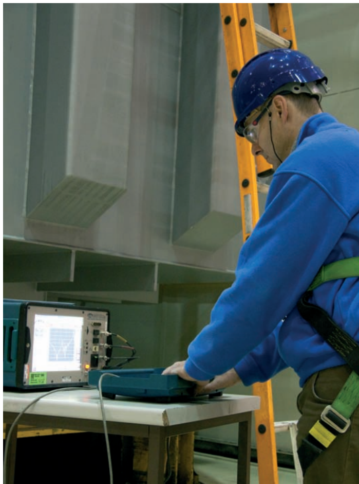
Во время тестов каждый трансформатор помечается SFRA подписью
