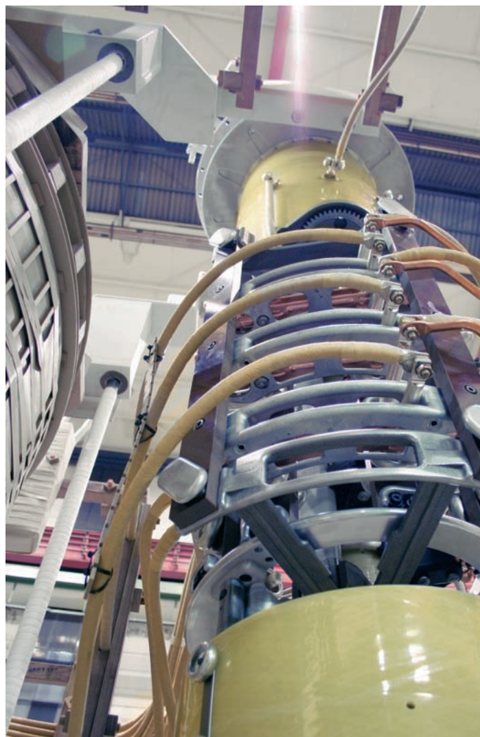
Вид снизу смонтированного РПН, тип Reinhausen M III 500 Y 72,5/B 10193W
