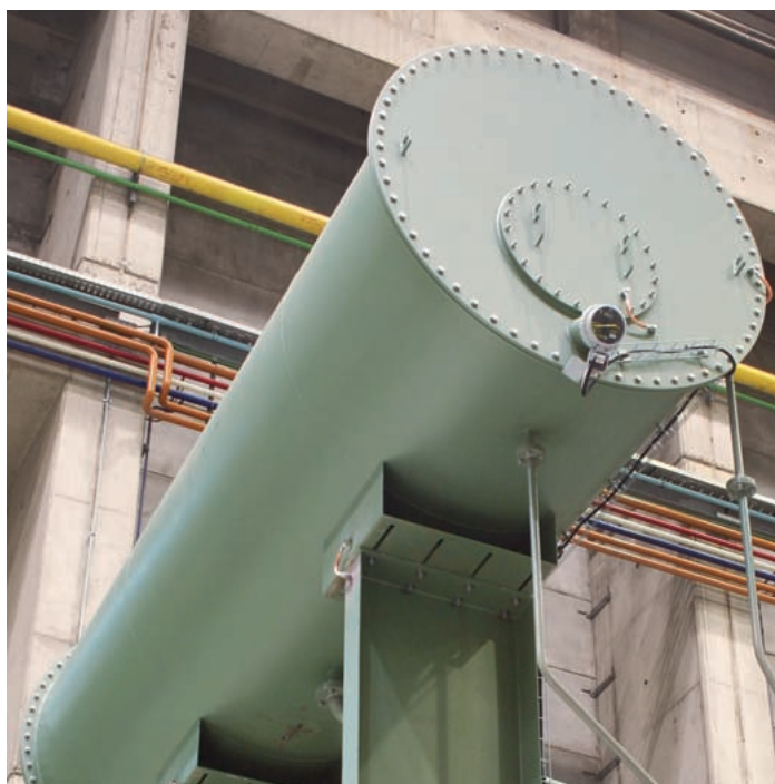
Расширитель с индикатором уровня масла для основного бака под углом 30°
