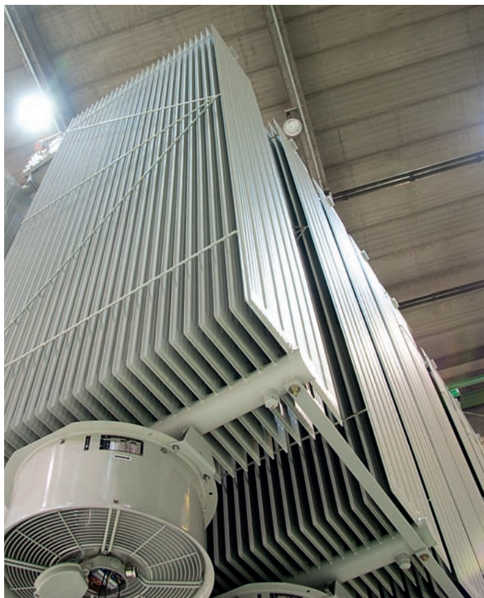
Устройство охлаждения трансформатора 750 МВА
