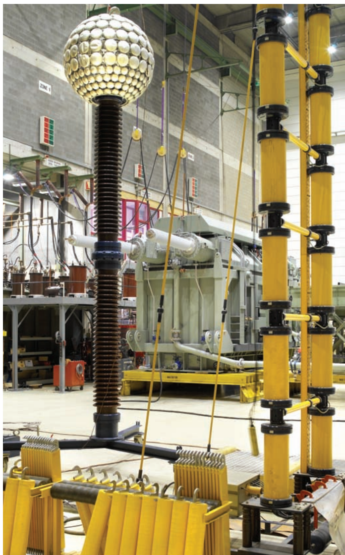
Подготовка к испытаниям генераторного трансформатора 150 МВА 235/34,5 кВ с системой принудительно-масляного и принудительно-воздушного охлаждения ODAF в соответствии со стандартами Немецких Железных Дорог.
